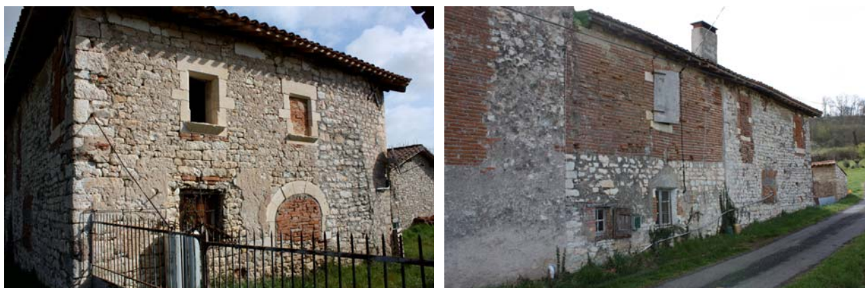
La façade sud de la construction du 16 e s. avec ses ouvertures soignées en pierre de taille
